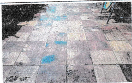
Sustitución de piso de concreto a piso cerámico
