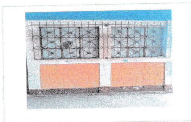
Sustitución de balcones metálicos a balcones metálicos de
