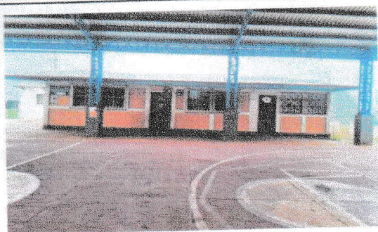
Sustitución de lámina a lámina troquelada color rojo calibre 26
