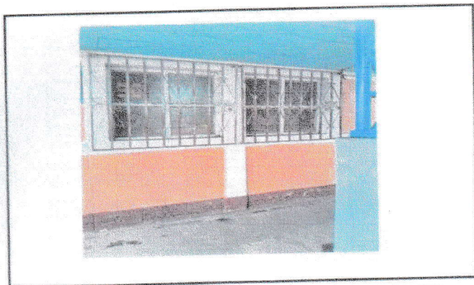
Mantenimiento de pintura de balcones metálicos de comedor escolar
