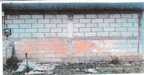
Mantenimiento de de pintura de muro en comedor escolar
