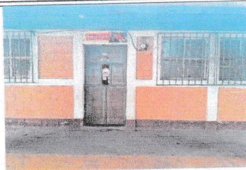
Matenimiento de puerta metálica en comedor esolar
