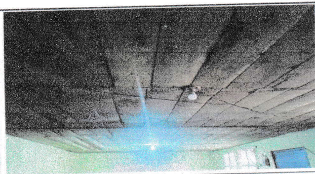
Sustitución de cielo falso de machimbre a cielo falso PVC en comedor escolar
