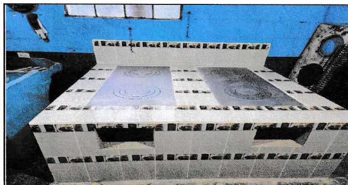
Foto 3: Sustrucción de estufa doble de ladrillo en cocina + planchas de metal
