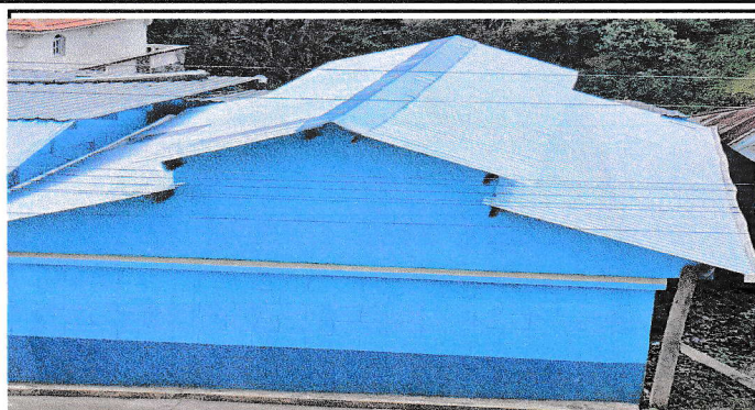
Foto 2: Sustrucción de lamina troquelada cal.26 en aula y patio
