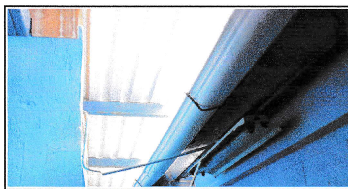
Foto 6: Sustrucción de canal Aluzinc en cubierta
