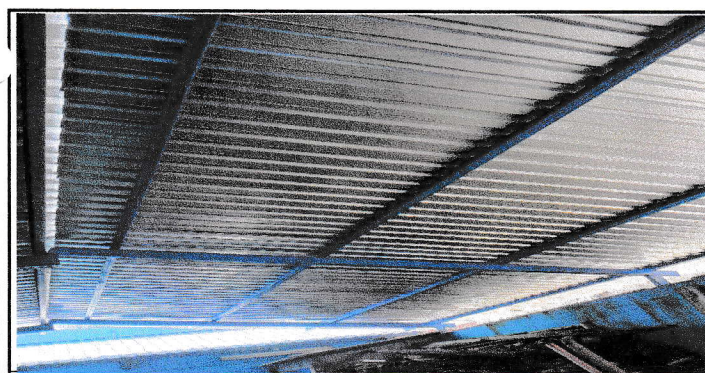
Foto 5: Sustrucción de lámina de patio
