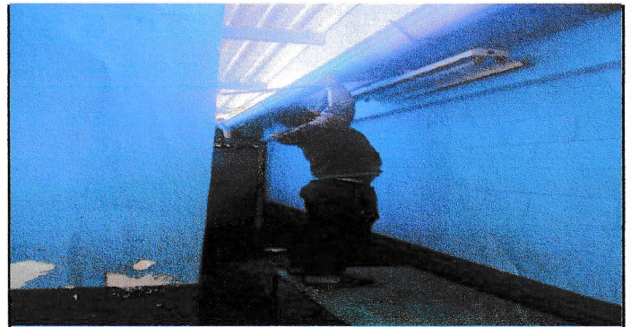
Foto 6: Sustitución de canal Aluzinc en cubierta
