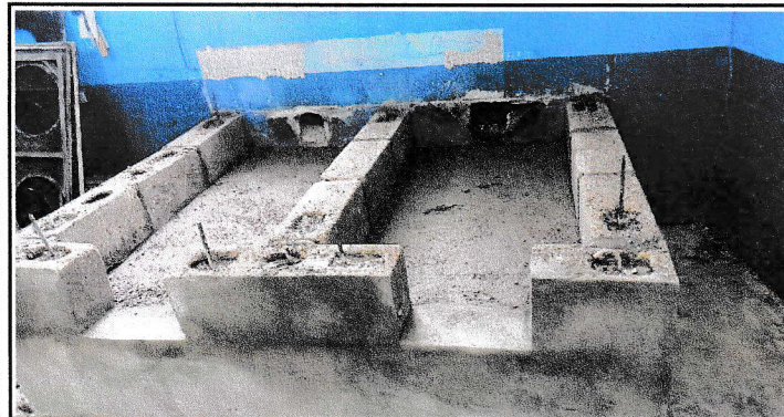
Foto 3: Sustitución de estufa doble de ladrillo en cocina + planchas de metal
