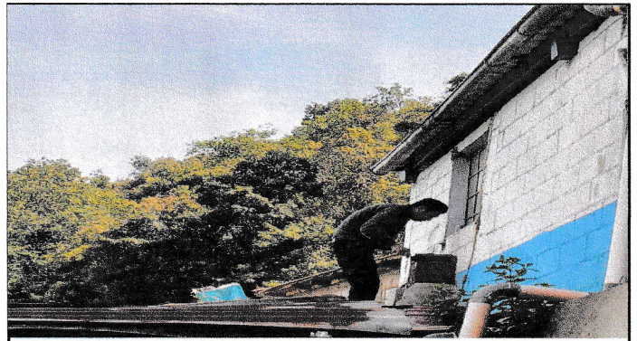
Foto 4: Sustitución de chimenea de ladrillo para estufa
