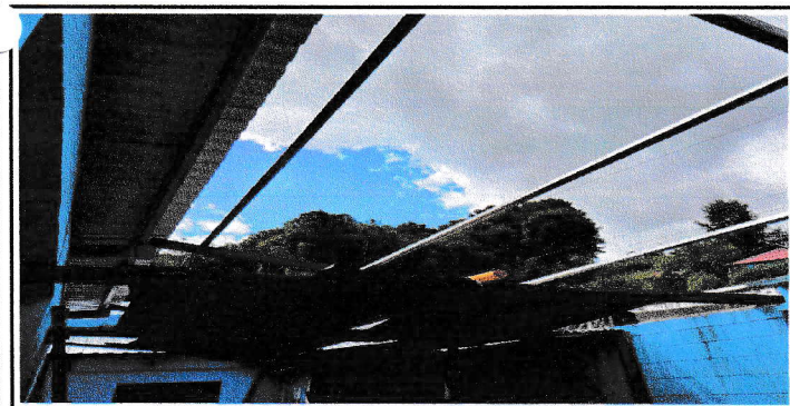
Foto 5: Sustitución de lámina de patio
