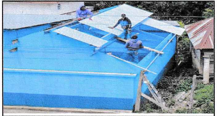
Foto 2: Sustitución de lamina troquelada cal.26 en aula y patio
