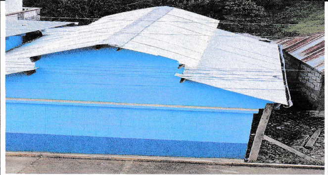
No.2 Sustitución de lamina troquelada cal.26 en aula y patio
