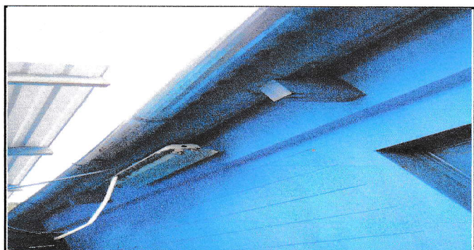
No.6 Sustitución de canal Aluzinc en cubierta
