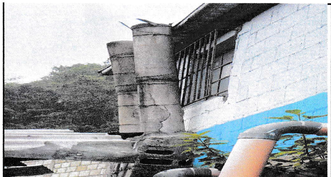
No.4 Sustitución de chimenea de ladrillo para estufa
