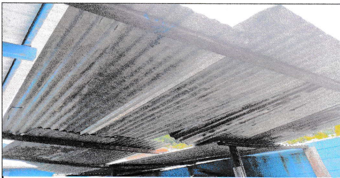
No.5 Sustitución de lámina de patio
