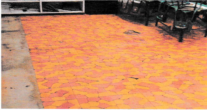
No.1 Sustitucion de piso ceramico en aula
