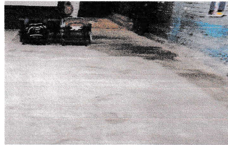
Reparación de piso de torta de cemento
