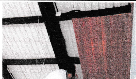
Sustitución de cielo falso con machimbre
