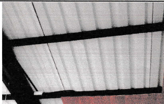
Sustitución de cielo falso con machimbre
