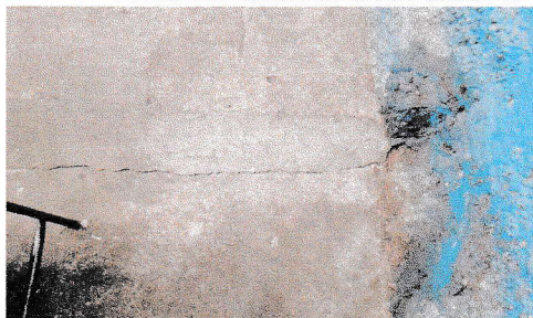
Reparación de piso de torta de cemento
