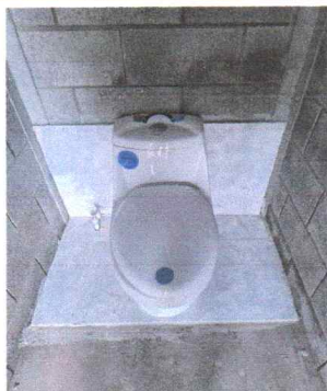
Foto 3: Colocación de tasas de baños
