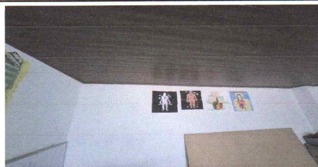
Foto 6: Colocación de cielo falso de PVC en una aula
