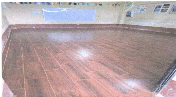
Foto1: Colocacion de piso ceramico en una aula
