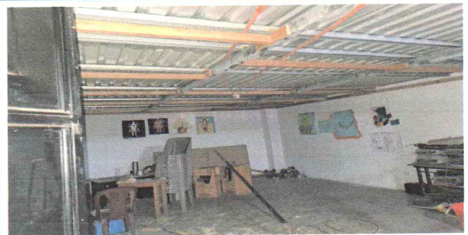
Foto 6: Inicio y Colocación de base para la colocación del cielo falso en una aula.
