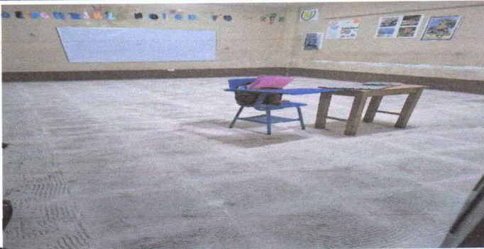
Foto 1: Inicio y levantamiento de piso en el Aula.
