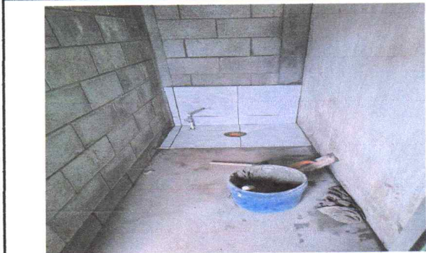
Foto 4: Levantamiento y Cambio de la tasa de Baños.
