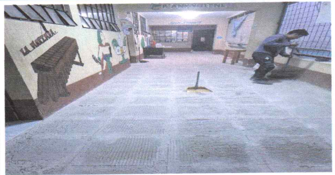
Foto 2: inicio y levantamiento de piso del corredor.
