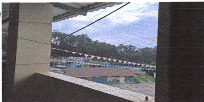
Mantenimiento y sustitución de malla galvanizada por balcón metálico en el corredor de terraza.
