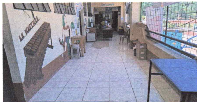
Mantenimiento y cambio de piso cerámico en el corredor de terraza.
