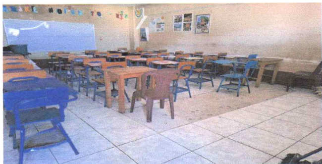
Mantenimiento y cambio de piso cerámico en una aula.
