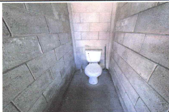
Mantenimiento y cambio de tazas de baño
