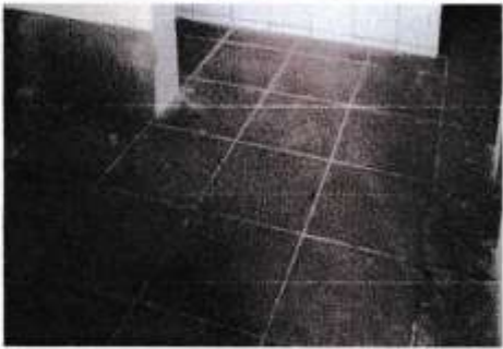
Piso sera mico de 5 mm en cocina
