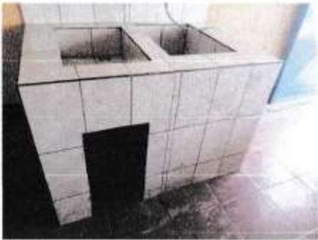
Sustitución de tubería de drenaje y agua potable para lavatrastos
