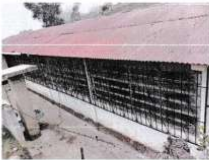
Mantenimiento de ventana metalica
