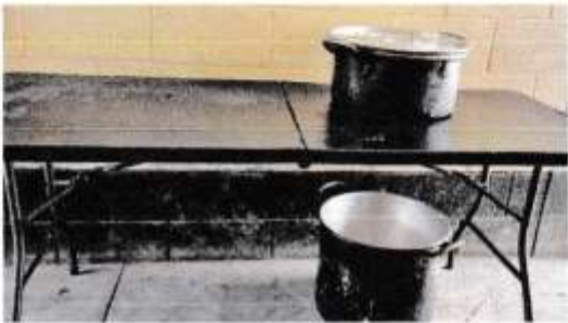
Sustitucion de mesa de trabajo + revestimiento de azulejo
