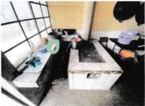
Sustitución de estufa rural de ladrillo + revestimiento de azulejo
