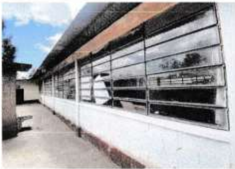
Mantenimiento de ventana metalica
