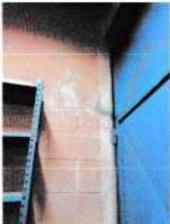
Mantenimiento de puerta metálica de cocina y bodega
