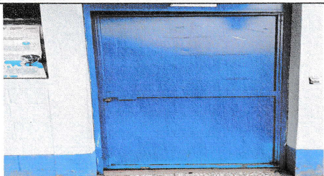
Mantenimiento y recorte de puertas metálicas.
