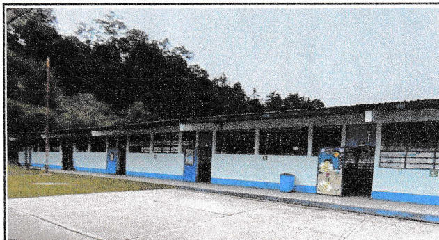
Mantenimiento y recorte de puertas metálicas.
