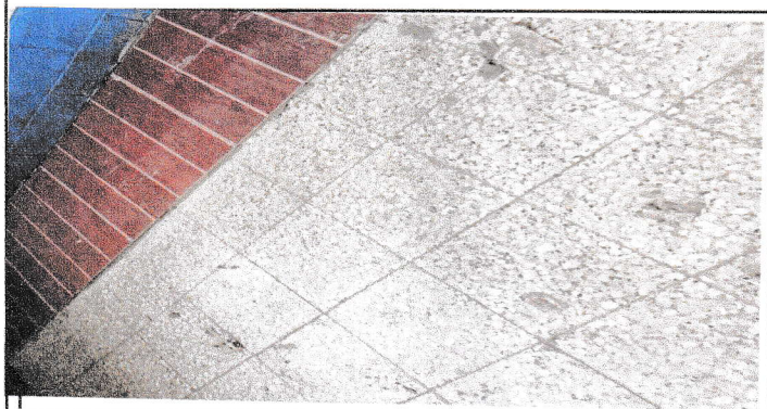
Mantenimiento sustitución de piso granito a piso cerámico
