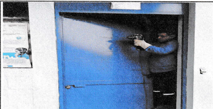
Mantenimiento y recorte de puertas metálicas.
