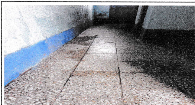
Mantenimiento sustitución de piso granito a piso cerámico
