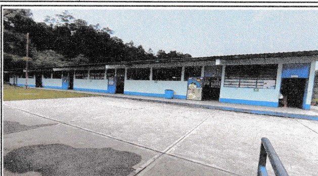
Mantenimiento y recorte de puertas metálicas.
