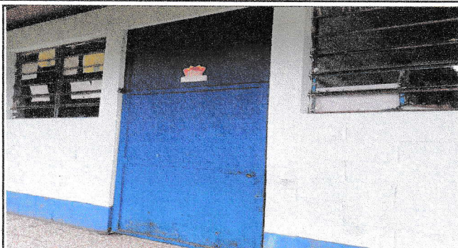
Mantenimiento y recorte de puertas metálicas.
