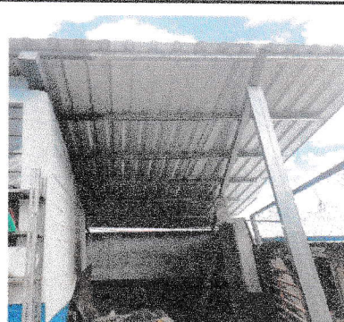
Sustitución de soporte de madera por estructura de metan de techo de cocina.
