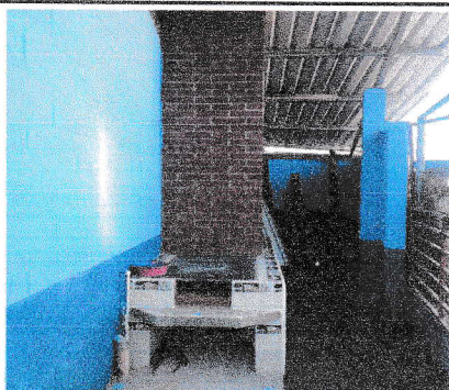
Sutitucion de pollo para cocinar por 2 planchas de cocina con leña y chimenea de ladrillo.
