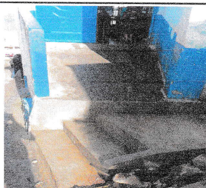
Sustitucion de gradas en entrada de módulo de segundo nivel.
