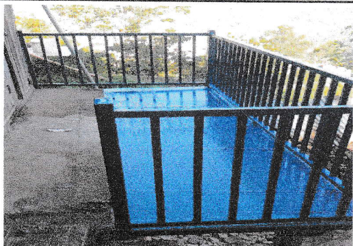
Sustitución de pasillo de soporte de madera por estructura de metal con barandas modulo de baños
