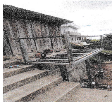
Sustitucion de Baranda de madera por metal frente a servicios sanitarios.
