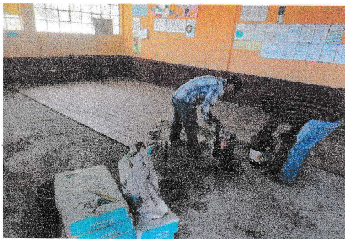
Sustitución de piso de marmol a piso cerámico en aulas de primer nivel.
