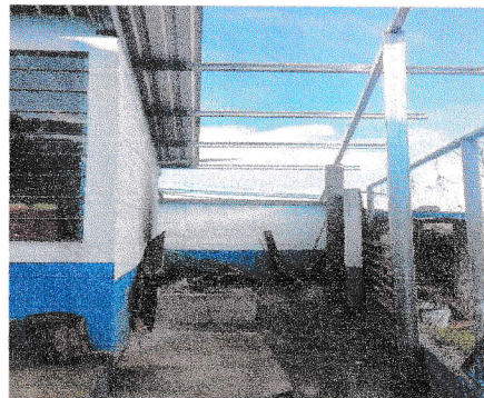
Sustitución de soporte de madera por estructura de metan de techo de cocina.
