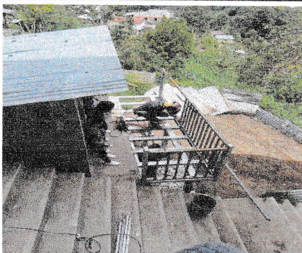
Sustitución de pasillo de soporte de madera por estructura de metal con barandas modulo de baños
