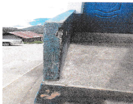
Sustitucion de gradas en entrada de módulo de segundo nivel.
