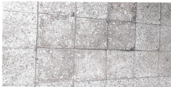
Sustitución de piso de marmol a piso cerámico en aulas de primer nivel.
