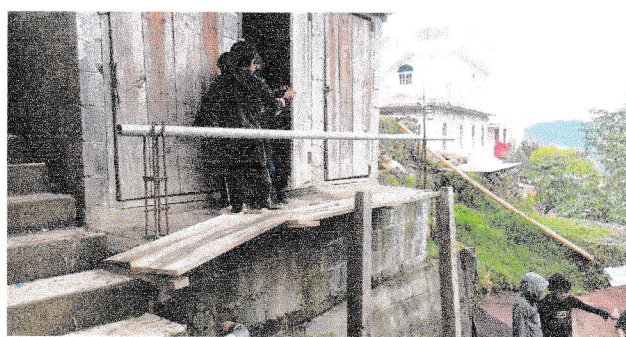
Sustitucion de Baranda de madera por metal frente a servicios sanitarios.
