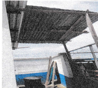
Sustitución de soporte de madera por estructura de metan de techo de cocina.
