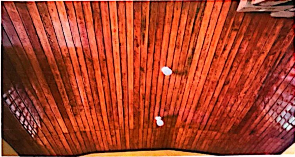
Foto 1: Sustrución de Machimbre para aulas y cocina
