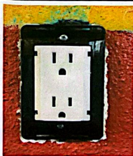
Foto 5: Sustitución de tomacorrientes dobles
