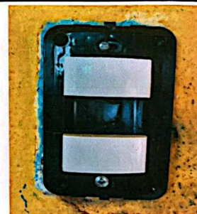
Foto 6: Sustitución de interruptores dobles
