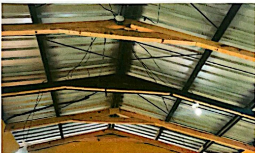
Foto 1: Sustitución de Machimbre para aulas y cocina
