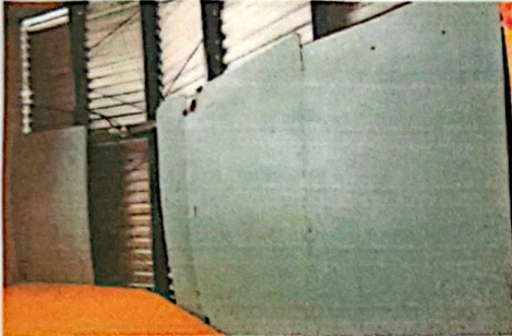
Sustitución de machimbre para aulas y cocina
