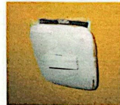
Sustitución de interruptores dobles
