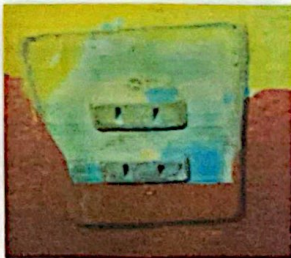
Sustitución de Tomacorrientes dobles
