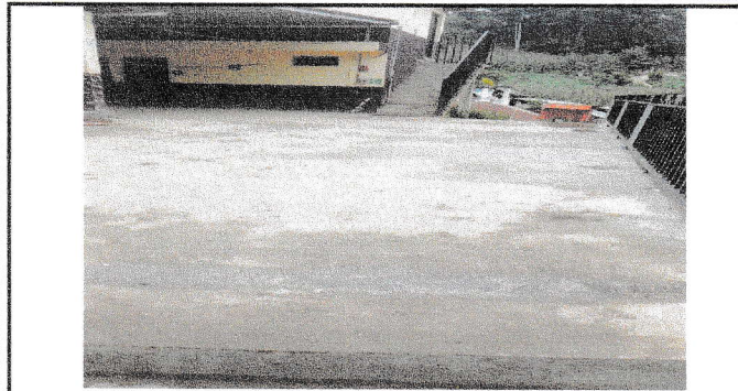
Mantenimiento correctivo a planchas de concreto y Sustitución de piso de concreto en patio.
