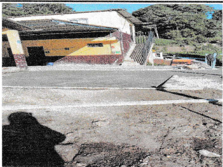
Mantenimiento correctivo a planchas de concreto y Sustitución de piso de concreto en patio.
