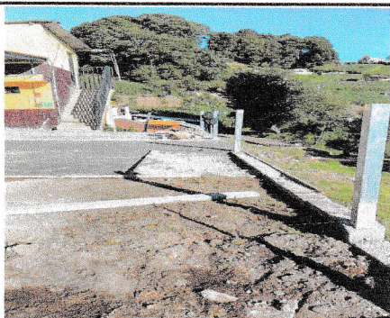
Sustitucion de estructura metalica por instalacion de baranda de metal en patio
