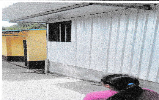
Sustitucion de estructura de metal de ventana.
