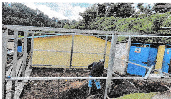
Sustitucion de estructura de soporte de madera por estructura de metal.
