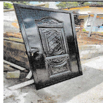
Sustitucion de puerta metalica.
