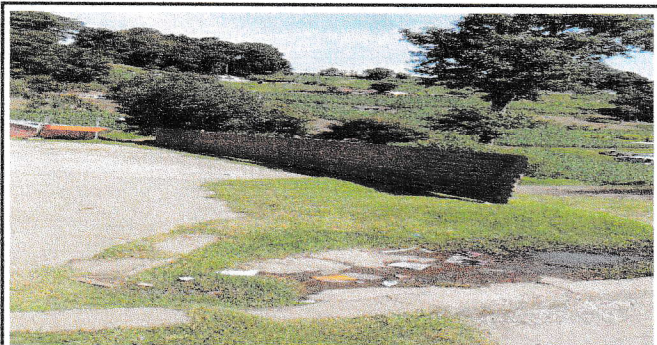
Sustitucion de estructura metalica por instalacion de baranda de metal en patio
