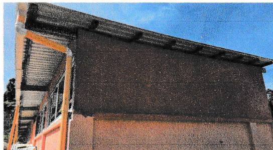
No.6 Sustitución de postes de madera a metal galvanizado en aulas de segundo nivel en módulo No. 3
