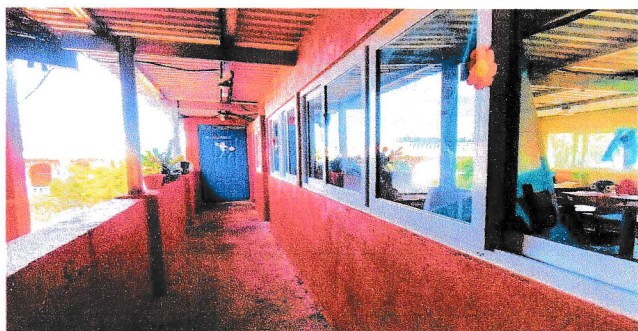
No.3 Mantenimiento correctivo de Aulas de estructura de madera por paredes con DUROCK de microconcreto del segundo nivel en modulo No. 3
