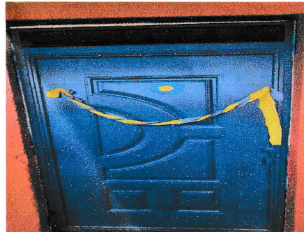
No.2 sustitución de puertas de madera a puertas de metal en segundo nivel modulo No. 3
