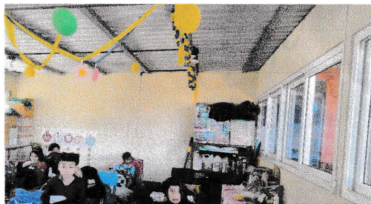
No.4 Mantenimiento correctivo de Aulas de estructura de madera por paredes con DUROCK de microconcreto en segundo Nivel del modulo No. 3
