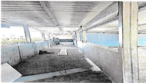
No.3 Mantenimiento correctivo de Aulas de estructura de madera por paredes con DUROCK de microconcreto del segundo nivel en modulo No. 3
