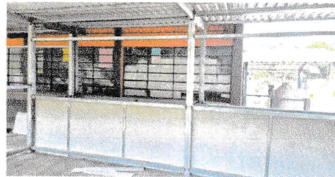
No.4 Mantenimiento correctivo de Aulas de estructura de madera por paredes con DUROCK de microconcreto en segundo Nivel del modulo No. 3
