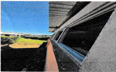
No.5 Sustitución de postes de madera a metal galvanizado en aulas de segundo nivel del módulo No. 3
