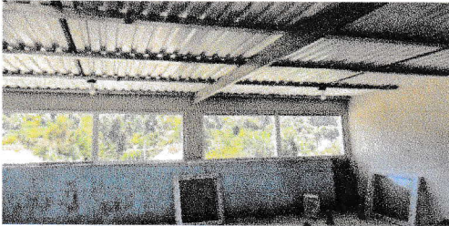
No.1 Sustitución de ventanas de lámina a ventanas UPVC de segundo nivel en módulo No. 3
