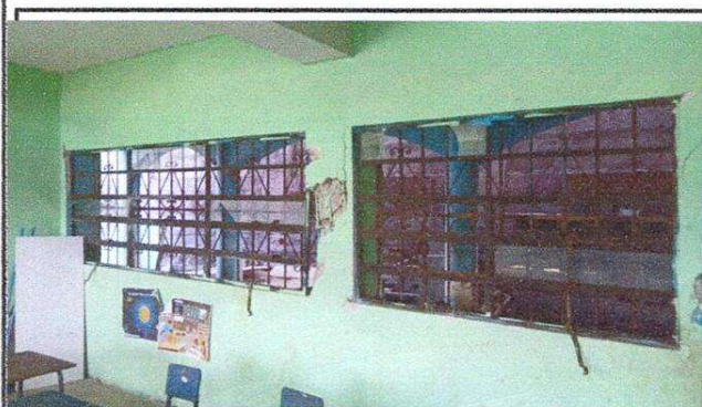
Foto 5: aula N. 2 reparacion de vidrios en aula
