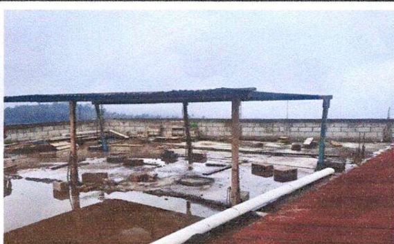
Foto 3: sustitucion de canal pluvial bajada de agua
