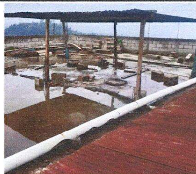
Foto 2: cambio de estructura de madera por metalica
