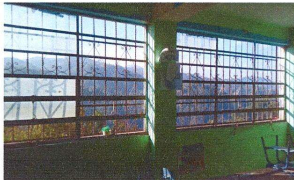
Foto 4: aula N. 1 reparacion de vidrios en estructura metalica
