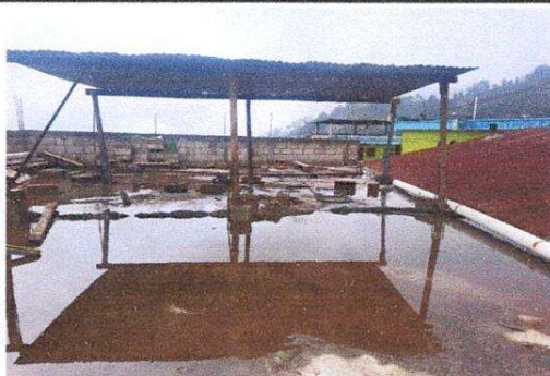
Foto 1: sustitucion de lamina por lamina troquela calibre 26
