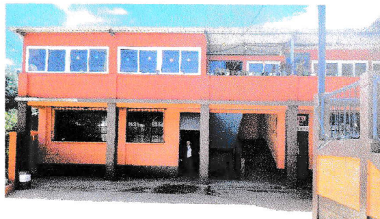
No.2 Sustitución de Lámina a lámina troquelada calibre No. 26 0.40 en segundo nivel modulo No. 3
