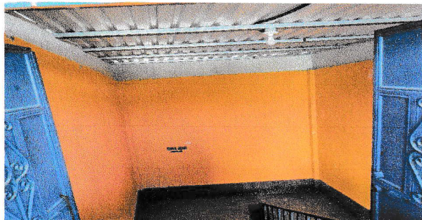
No. 1 Sustitución de Lámina a lámina troquelada calibre No. 26 0.40 en segundo nivel modulo No. 3
