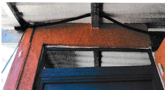
No.5 Sustitucion de cableado electrico No. 10 AWG en aulas de segundo nivel del modulo No. 3
