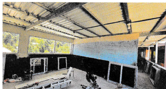
No.4 Sustitución de estructura de soporte de madera por estructura de Metal galvanizado en aulas segundo nivel del modulo No. 3
