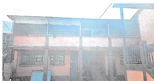
No.2 Sustitución de Lámina a lámina troquelada calibre No. 26 0.40 en segundo nivel modulo No. 3
