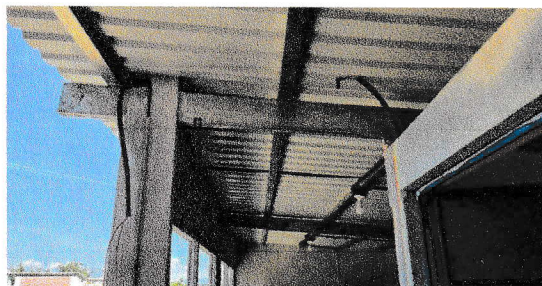
No.5 Sustitucion de cableado electrico No. 10 AWG en aulas de segundo nivel del modulo No. 3
