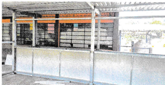
No.3 Sustitucion de cableado electrico No. 10 AWG en aulas de segundo nivel del modulo No. 3
