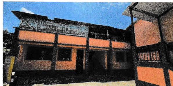
No.2 Sustitución de Lámina a lámina troquelada calibre No. 26 0.40 en segundo nivel modulo No. 3
