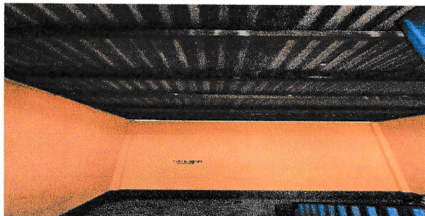
No. 1 Sustitución de Lámina a lámina troquelada calibre No. 26 0.40 en segundo nivel modulo No. 3
