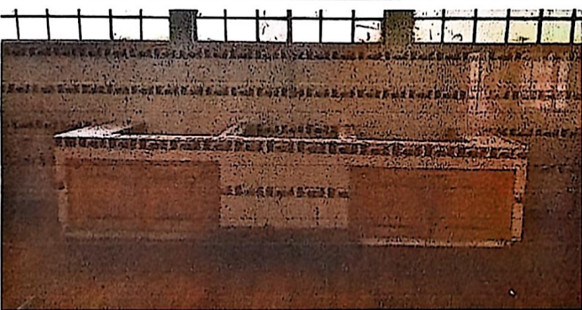
Foto 3: SUSTITUCION DE PILA POR LAVATRASTOS
