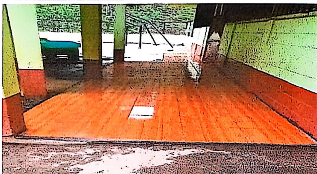
Foto 1: SUSTITUCION DE PISO DE CONCRETO A CERÁMICA EN PASILLO DE 2.22 X 12.6
