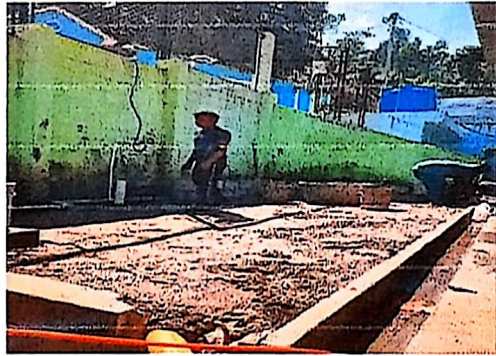
Foto 4: MANTENIMIENTO DE TORTA DE CEMENTO EN PATIO DE TIERRA DE 3.10 X 6
