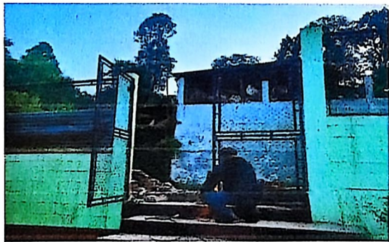
Foto 6: SUSTITUCION DE PORTON DE MALLA A ELECTROMALLA DE 2.20 X 2.30
