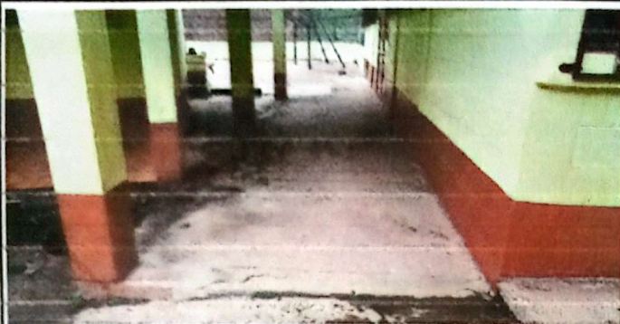
Foto 1: SUSTITUCION DE PISO DE CONCRETO A CERÁMICA EN PASILLO DE 2.22 X 12.6
