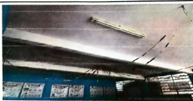
Foto 5: SUSTITUCION DE LÁMPARAS A FOCOS
