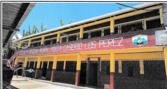
Mantenimiento de muro con suministro y aplicación de pintura latex en exterior en aulas de modulo 1
