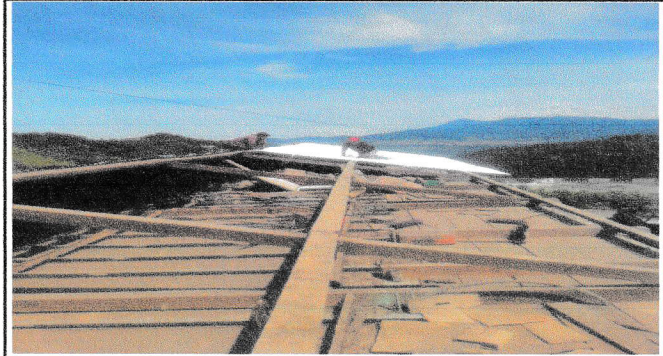
Sustitucion de lamina acanalada por lamina troquelada calibre 26 en aulas de modulo 1 , Sustitucion de canales de metal en aulas de modulo 1
