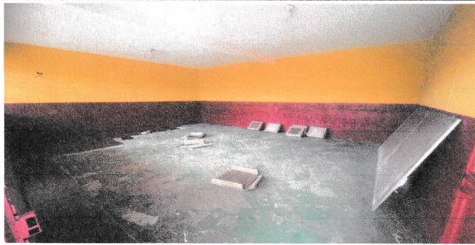
Sustitución de piso de concreto a piso cerámico en aulas de modulo 1
