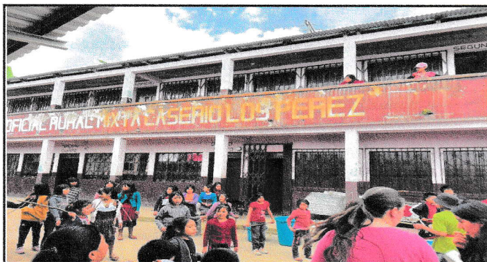
Mantenimiento de muro con suministro y aplicación de pintura latex en exterior en aulas de modulo 1
