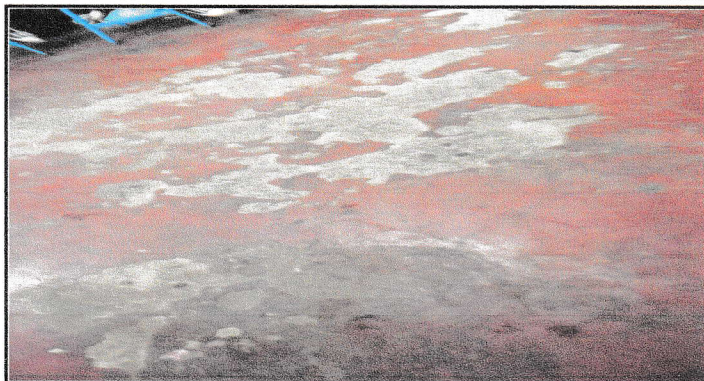
Sustitución de piso de concreto a piso cerámico en aulas de modulo 1
