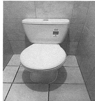
Foto 4: Sustitucion de inodoro
