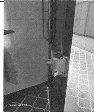
Foto 6: Cambio de chapa
