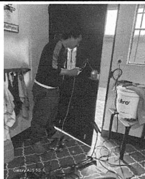
Foto 6: Cambio de Chapa
