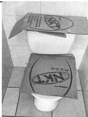
4. Sustitucion de inodoro
