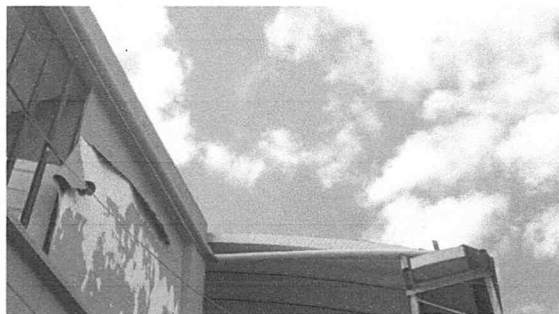
Foto 5: Bajadas de agua
