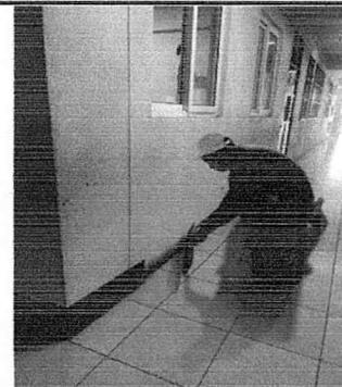
Mantenimiento sustitución zocalo de pintura por zocalo de piso
