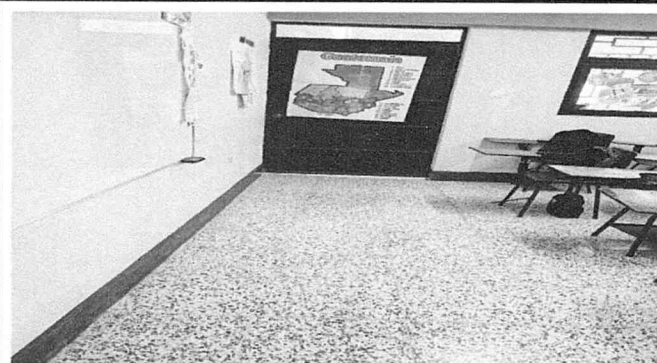
Mantenimiento de piso granito (pulido y lustrado) en aulas y en pasillos del primer y tercer nivel (391 m2).
