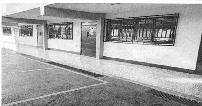
Mantenimiento correctivo de zócalo de pintura por zócalo de piso cerámico (700 ml)
