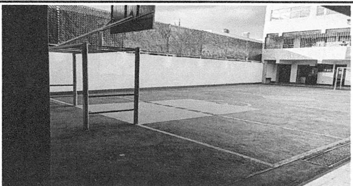
Mantenimiento de piso de cancha deportiva con suministro y aplicación de pintura de tráfico y señalización. (limpieza, resane y aplicación). (214 m2)
