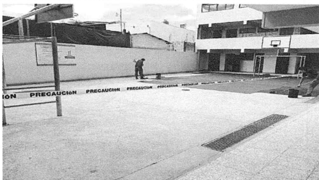
Mantenimiento de piso de cancha deportiva con suministro y aplicación de pintura de tráfico y señalización (limpieza, resane y aplicación). (214 m2)
