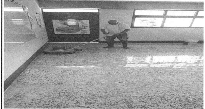
Mantenimiento de piso granito (pulido y lustrado) en aulas y en pasillos del primer y tercer nivel (391 m2).
