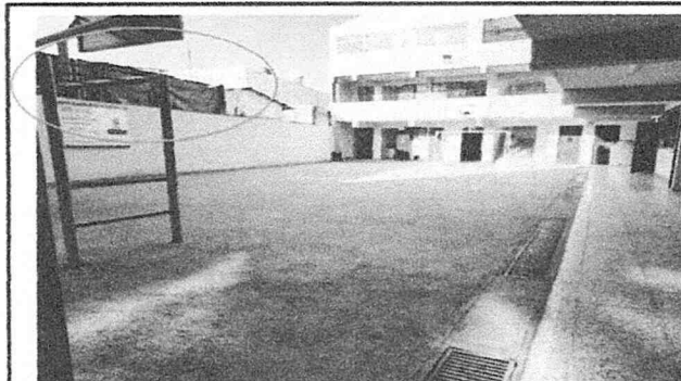
Sustitución de malla por malla galvanizada más privacinta en muro perimetral. (41 m2)
