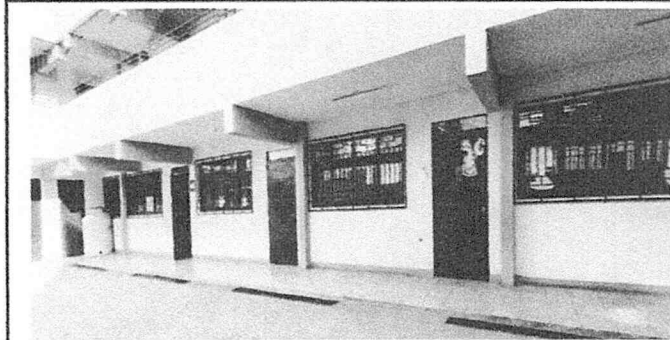
Mantenimiento correctivo de zócalo de pintura por zócalo de piso cerámico. (700 ml)
