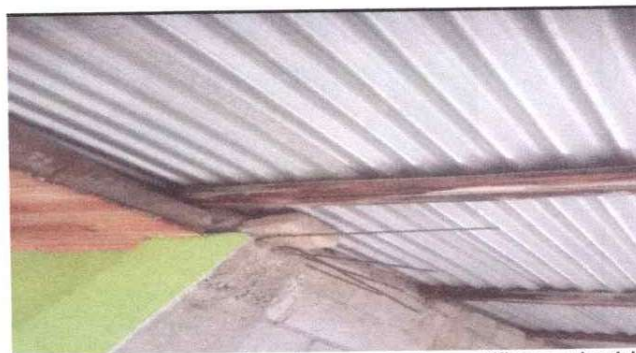
Sustitución de estructura de madera por estructura metálica en aulas del segundo nivel
