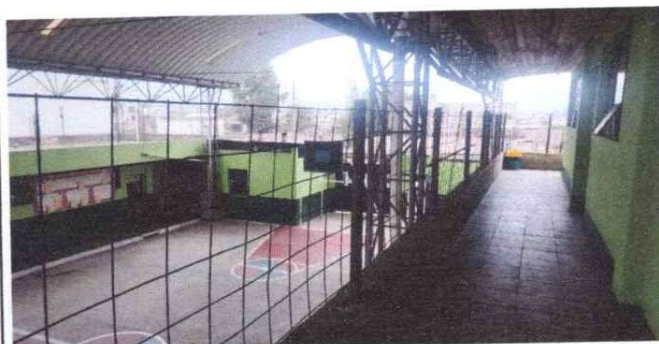
Sustitución de canal de PVC en corredor del segundo nivel.
