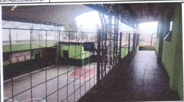
Sustitución de baranda con electromalla en corredor del segundo nivel.
