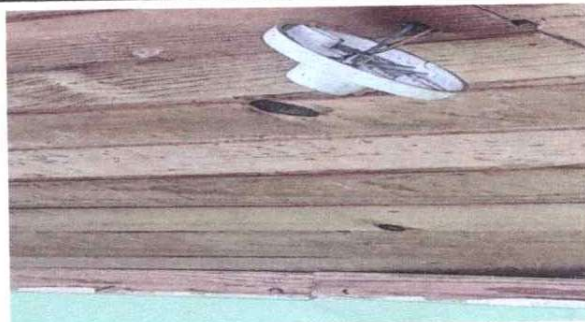
Sustitución de cableado eléctrico en 4 aulas y pasillo del segundo nivel
