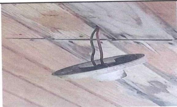
sustitución de cableado eléctrico en 4 aulas y pasillo del segundo nivel
