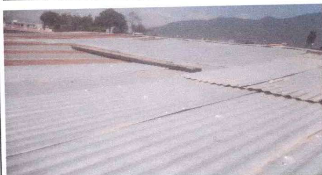
Sustitución de lámina troquelada aluzinc calibre 26 en 4 aulas del segundo nivel.
