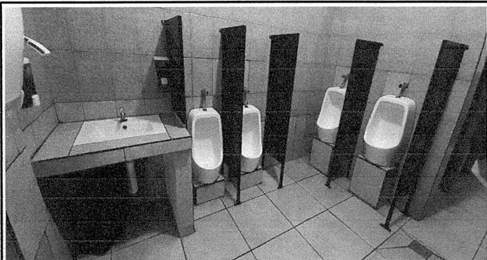
Sustitución de mingitorio y divisiones , Sustitución de lavamanos con mesa fundida
