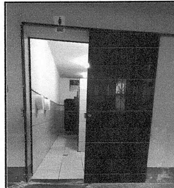
Sustitucion y mantenimiento de puertas
