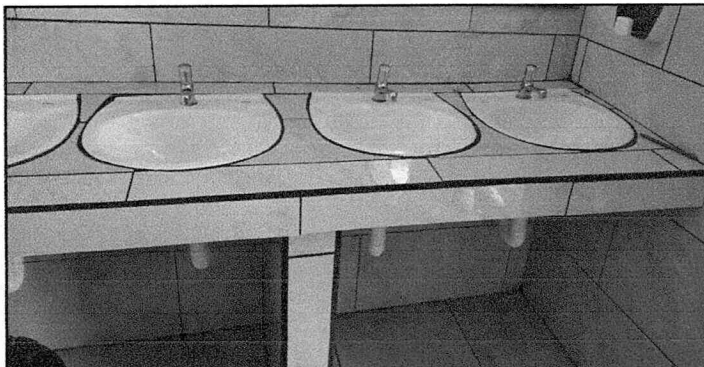
Susitucion de lavamanos de niñas
