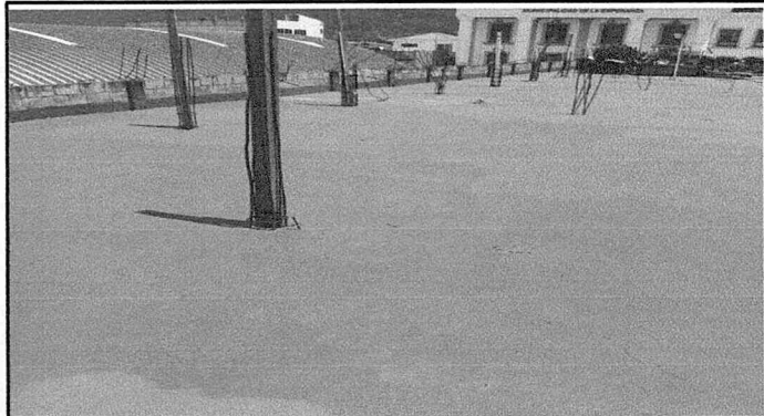
Mantenimiento de impermeabilización de terraza tercer nivel
