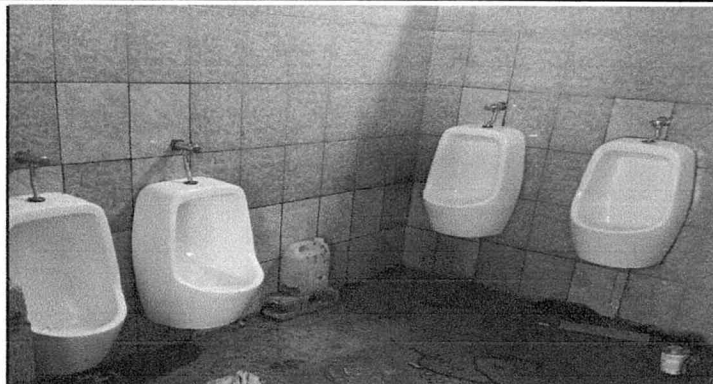
Sustitucion de mingitorio y divisiones , Sustitucion de lavamanos con mesa fundida
