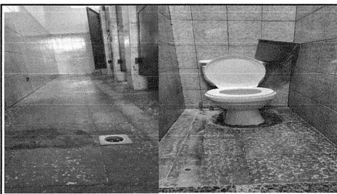
Sustitución de piso y sanitarios
