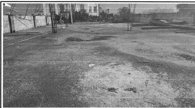
Mantenimiento de impermeabilización de terraza tercer nivel
