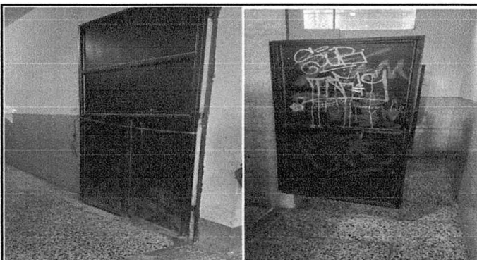
Sustitución y mantenimientos de puertas
