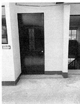
Sustitución de puerta en Lavandería
