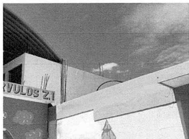
Mantenimiento correctivo (impermeabilización de muro exterior y resanado exterior y resanado interior)
