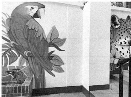
Aplicación de pintura interior, corredores primer nivel, cocina, rampa, jardinera, lavandería, puerta principal
