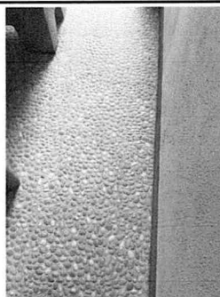
Sustitución de piso por antideslizante para lavandeería
