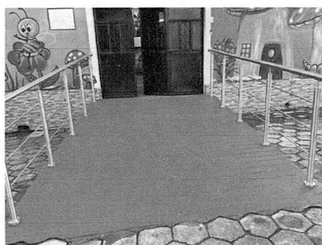
Sustitución de baranda en la rampa en tubo de acero inoxidable de la entrada principal
