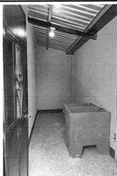
Sustitución de muro de laminas por muro prefabricado
