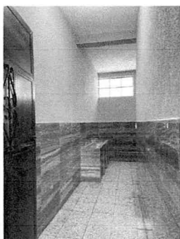
Sustitución de azulejo en sanitarios
