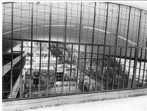
Mantemimientto correctivo de baranda con electro maya
