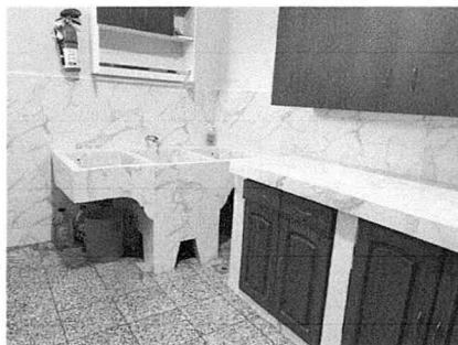
Sustitución de pila de cocina
