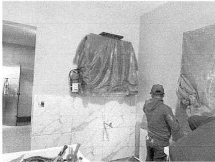
Sustitución de azulejo de Cocina por porcelanato
