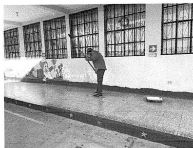
Sustitución de murales primer nivel
