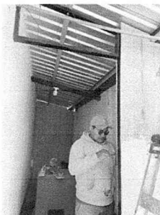
Sustitución de puerta en Lavandería
