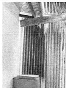
Sustitución de muro de laminas por muro prefabricado
