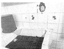
Sustitución de azulejo de Cocina por porcelanato (Material: Porcelanato, pega mix, monocapa, Porcelana, crucetas)
