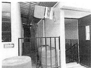
Sustitución de puerta en Lavandería
