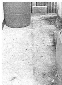
Sustitución de piso por antideslizante para lavandería
