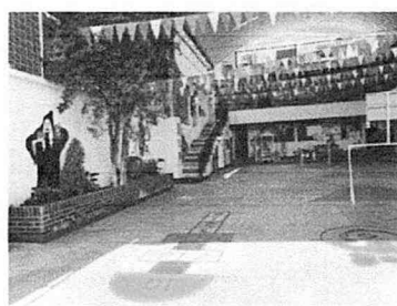
Sustitución de murales primer nivel
